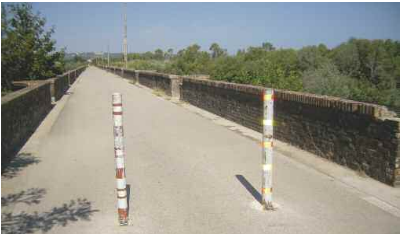
Ponte sul Fiume Sangro
